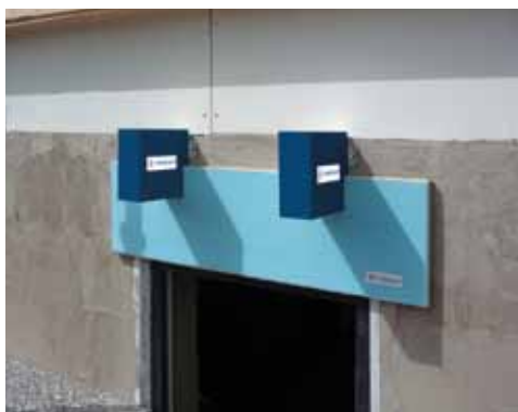
Příprava kotvení venkovní žaluzie bez tepelných mostů: s využitím izolace VakuPRO a montážních bloků PROPASIV®
